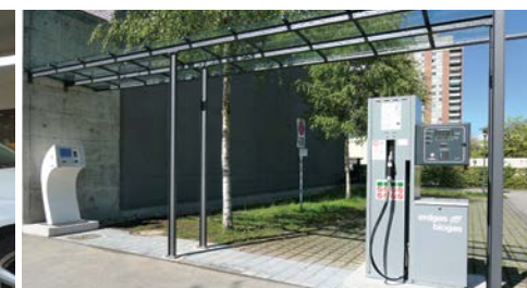
Neue Erdgastankstelle im Roggebode 1
